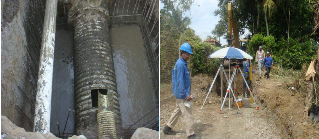
Proyecto Optimización y Ampliación de Redes de Alcantarillado del corregimiento Aguaclara – Fase III
