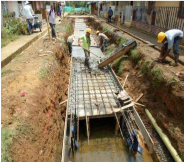
Construcción box culvert – Barrio Portal del Jordán-Villa del Sol Jamundí
