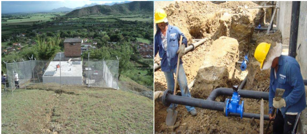
Construcción Acueducto de Corregimientos Morelia, Higuerón e Higueroncito en Roldanillo
