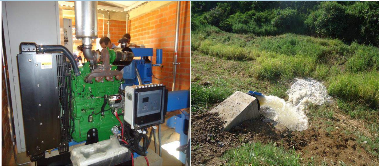
Estación de Bombeo de Aguas Lluvias - EBALL, Urbanización La Mezquita- Remansos, Sector La Morada Jamundí
