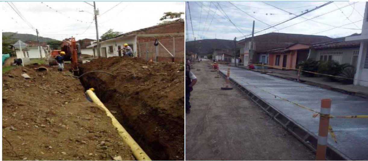
Construcción Colectores de Alcantarillado Cra 7 Y Calle 6 con Estructura de Separación – Yotoco
